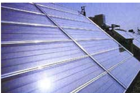
Fig. 2 Collettori solari piani (Jordano)
